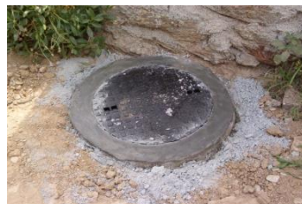
Figura 34 - Exemplo das fases de instalação duma caixa de ramal com tubo de elevação DN400
