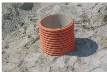
Figura 34 - Exemplo das fases de instalação duma caixa de ramal com tubo de elevação DN400
