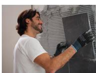
Colocar las baldosas presionándolas hasta conseguir el aplastamiento de los surcos del mortero cola y un buen macizado de la pieza. Comprobar periódicamente la pegajosidad de la pasta levantando la baldosa previamente colocada. Es aconsejable dejar juntas entre piezas colocando crucetas de 2 mm como mínimo en interiores y 5 mm en exteriores, rellenándolas con morteros de rejuntado de la gama **webercolor**.
