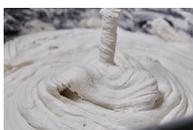
Amasar **webercol flex duogel** con 7 - 9 litros de agua limpia por saco de 25 kg con un batidor eléctrico lento (500 rpm) hasta obtener una masa homogénea y exenta de grumos. Dejar reposar la mezcla unos 2 minutos y realizar un ligero reamasado.
